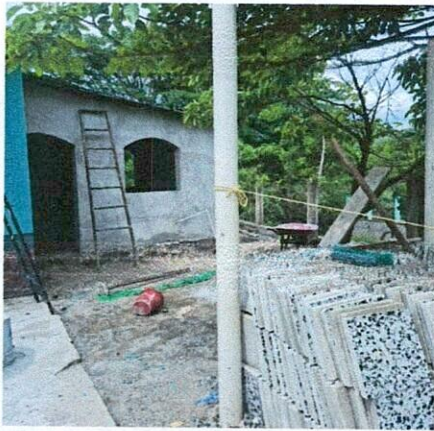
Foto 3: Proceso de remozamiento del área de cocina
