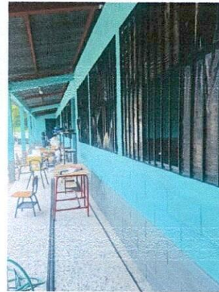
Foto 8: Mejoramiento de piso del corredor y pintura de balcones
