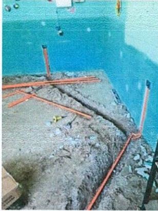
Foto 9: Cambio de la instalación eléctrica
