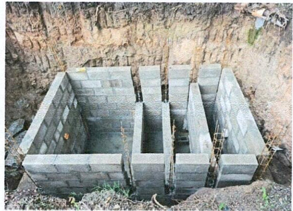
Foto 12: Construcción de nueva de fosa séptica
