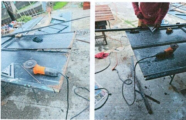
Foto 7: Corte, reparación y pintura de puertas
